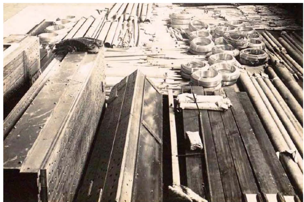
資材の一部（音響盤、木製管、金属管、送風管）
