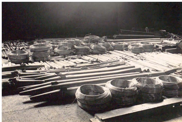
資材の一部（金属管、送風管）
