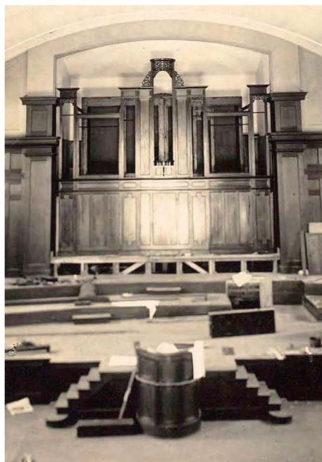
配管前の外枠工事
