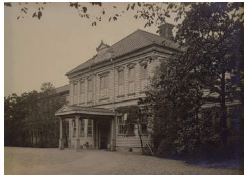
写真4 東京音楽学校奏楽堂 現在は上野公園に移設され、重要文化財「旧東京音楽学校奏楽堂」になっています。
