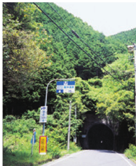
切目辻トンネル
