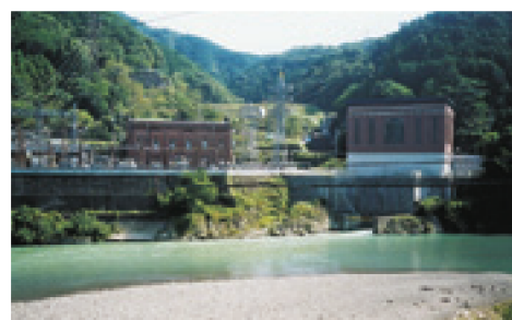
新高津尾発電所
