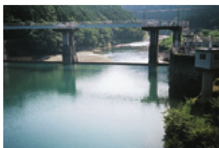
柳瀬発電所の取水ダム
