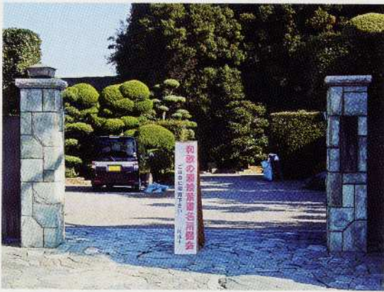
県公館の入口
