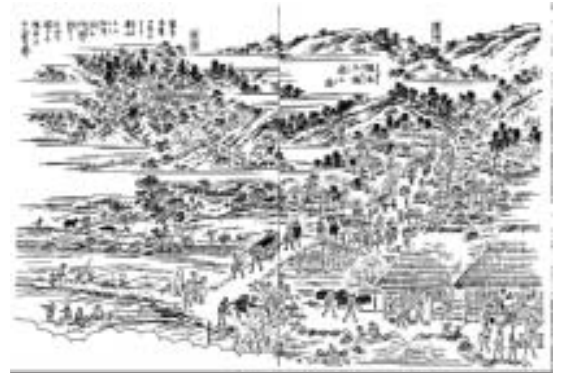
⑤図 加茂川に架る土橋
