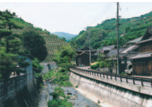
⑫図 右図現況。川沿いの道路は熊野古道です。
