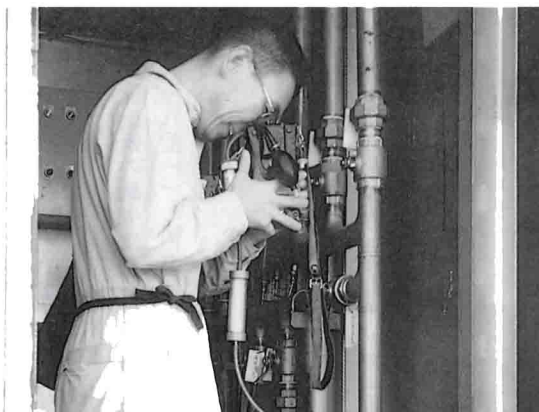
ガス濃度測定（有害なガスを使用するので慎重に）
