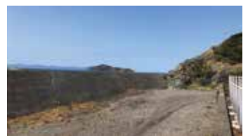
防潮堤と接続する大苧藻島
