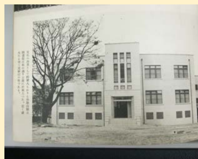
昭和13年に竣工した、旧和歌山県立図書館 「文化の源泉として待望久しかりし和歌山県立図書館は此の通り立派に出来上がった」と記載されています。
